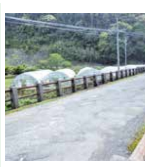
二ノ瀬橋のハウス
