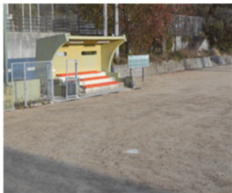
順調に改修が進んでいる 町民グラウンド
