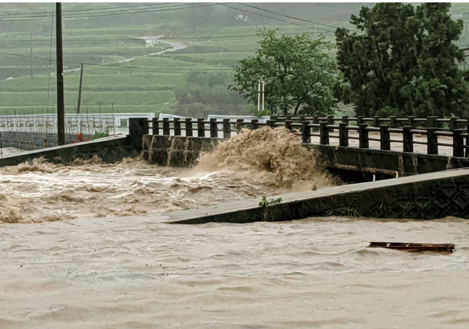
2020.7.6 氾濫した千綿川（昭和橋） 【消防第3分団撮影】
