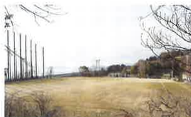
改修が待たれる町民グラウンド
