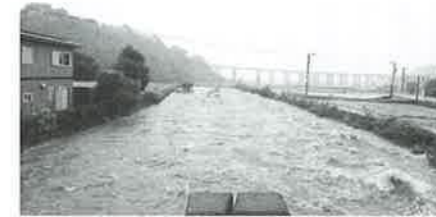
氾濫寸前の千綿川中流
