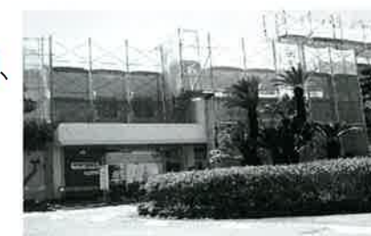
改修中の教育センター分室
