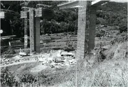
開通が待たれる広域農道（H24.4開通予定） 写真は八反田地区の橋梁工事
