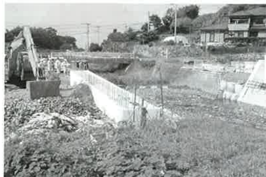
（木場本線橋梁護岸工事）
