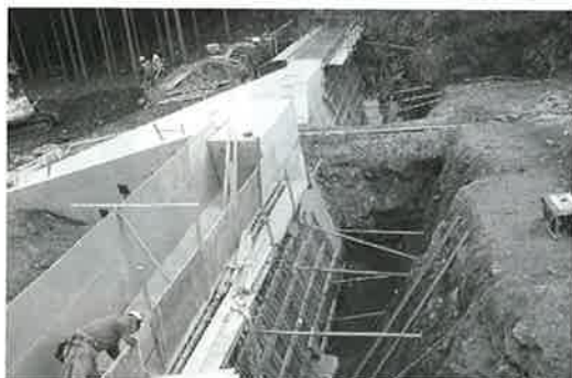
（原田地区排水路整備工事）
