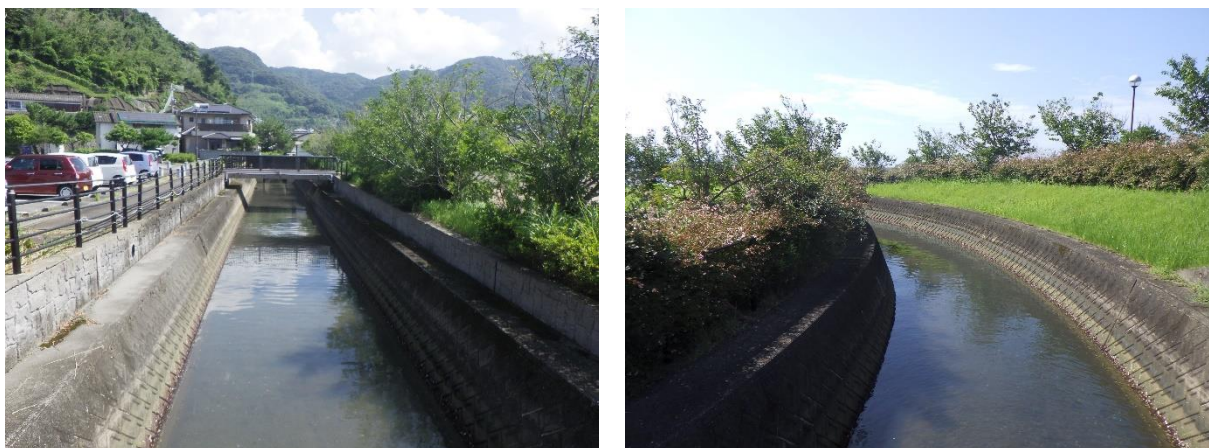
図 4-3 令和 5 年 7 月の島田川の様子（左：上流側、右：下流側）
