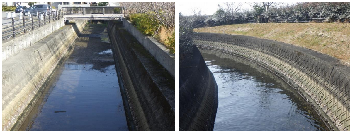
図4-1 令和6年2月の島田川の様子①（左：上流側、右：下流側）
