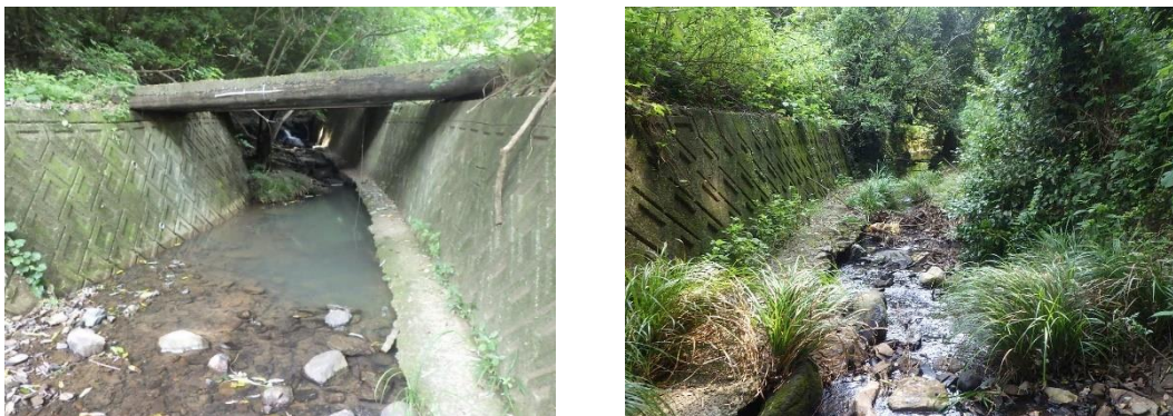
図 4-7 才貫川①（上流）（左：上流側、右：下流側 どちらも R7.7.17 撮影）
