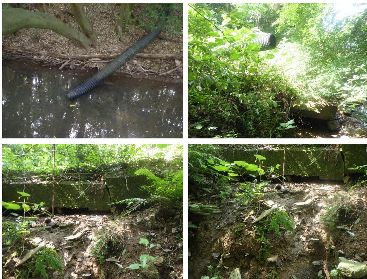
図 3-7 養鶏場からの排水管 (R7. 7. 17 撮影)
