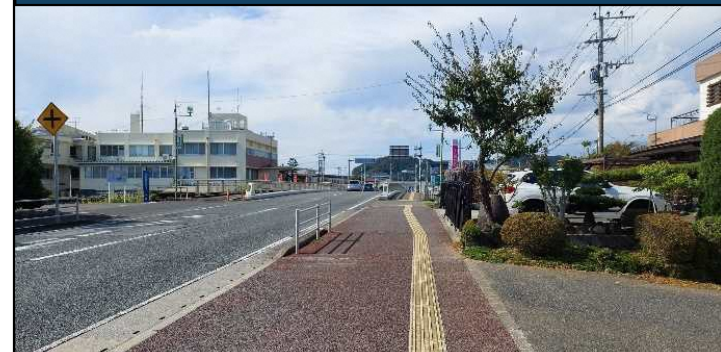
Cからの現況写真 国道205号 (41条1項)
