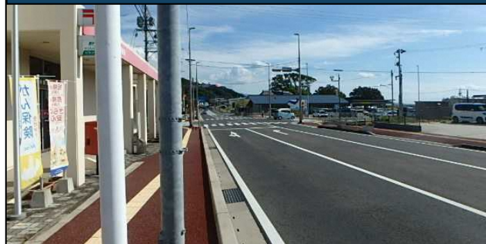
Bからの現況写真 国道205号（42条1項）
