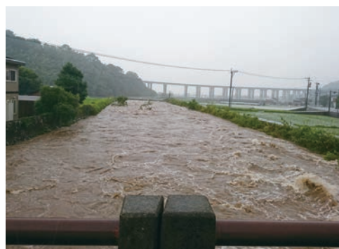
▲昭和橋からみる千綿川の様子
