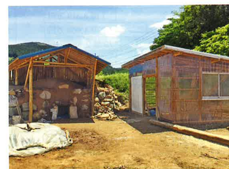
▲完成した炭焼き窯と炭小屋
