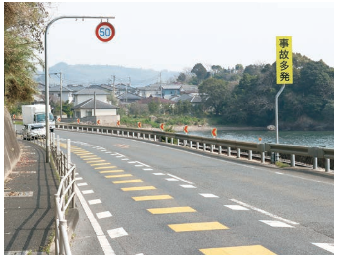
▲三連ドット施工後の現地の様子
