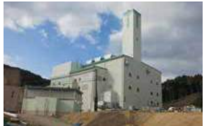
▲東彼杵地区清掃工場(川棚町)
