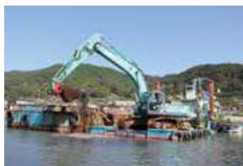
▲音琴漁港保全工事
