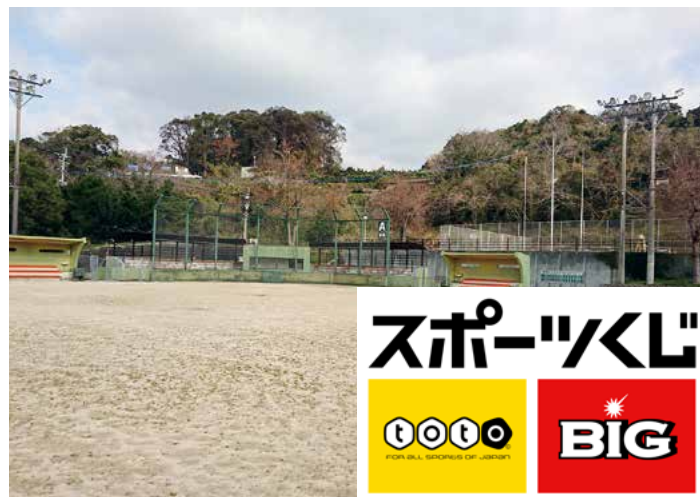
▲ 改修前の町民グラウンド
