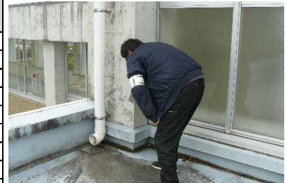
劣化状況調査風景
