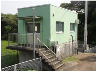
赤木工業団地 第1水源地・浄水場
