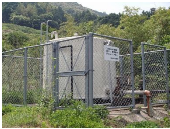
山田住宅高台地区配水池
