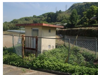
高峰加圧ポンプ所
