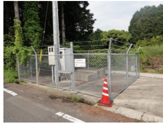
赤木工業団地 第2水源地
