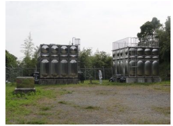
赤木工業団地 第1・第2配水池
