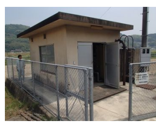
山田水源地・浄水場
