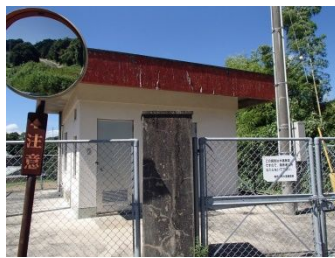
里浄水場・中継ポンプ所
