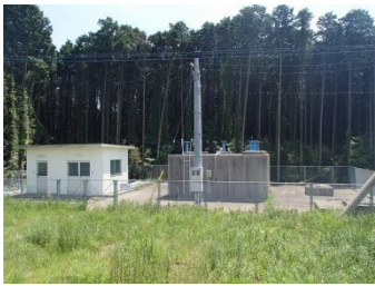
中岳水源地・浄水場・配水池
