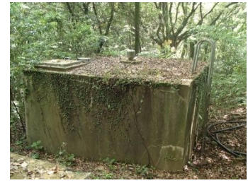
太ノ浦配水池
