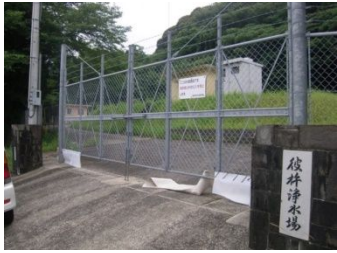
彼杵浄水場・配水池
