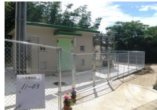
木場・一ツ石中継ポンプ所
