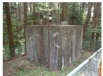
中川内配水池
