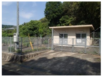
中尾第1水源地・浄水場
