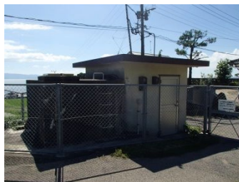
才貫田浄水場・中継ポンプ・ 低区配水池
