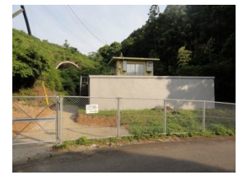
千綿浄水場・配水池
