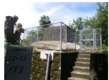
才貫田高区配水池
