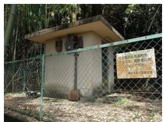
柚木町水源地
