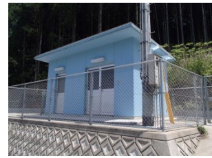
遠目水源地・浄水場
