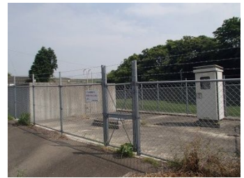
赤木第2配水池
