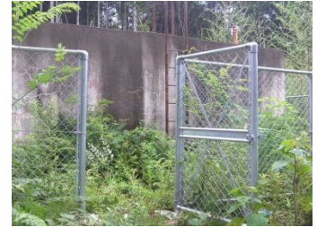
法音寺配水池
