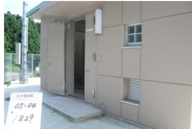
中尾・太ノ浦中継ポンプ所
