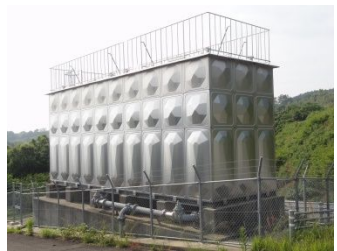
千綿第2配水池
