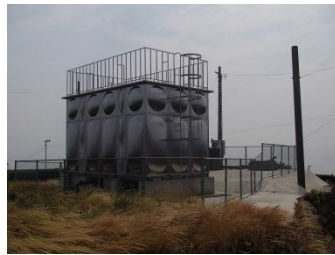
赤木第1配水池
